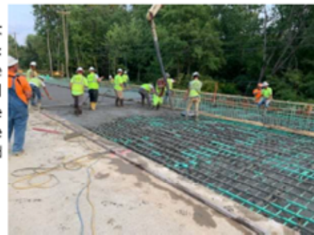
Figure 2: 96 th Street Bridge Deck Pour
